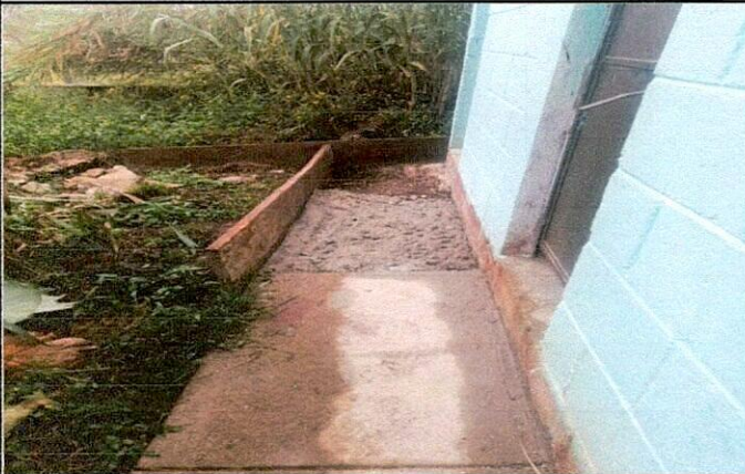
Foto 3: Realización de banqueta para unir los baños, mejoramiento de baños, instalación de agua con tubería de P.V.C. Entre otros
