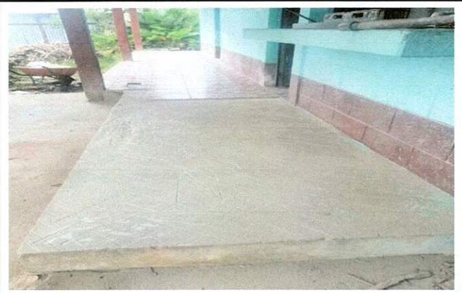
Foto 4: Instalación de piso granito, corredor de cocina y bodega.
