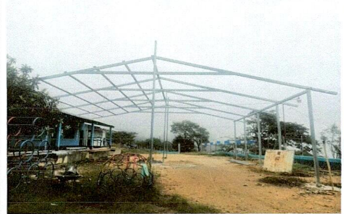
Foto 2: Instalación de techo con estructura tipo pórtico, con cobertura de lámina troquelada calibre 26.
