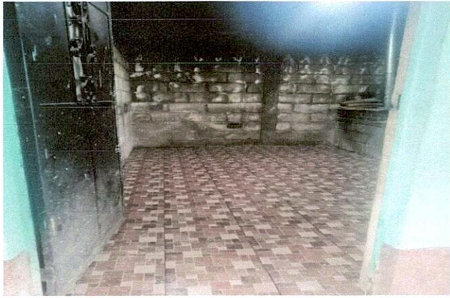
Foto 1: Mejoramiento de cocina, pintura, cambio de ventana por cortina metálica, cambio de loza por piso de cerámico.
